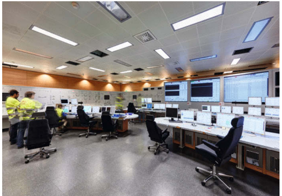
Warte des Europäischen Druckwasserreaktors (EPR) Olkiluoto 3 in Finnland während der Inbetriebsetzung: Der von Framatome und Siemens entwickelte Reaktor ist der letzte AKW-Typ mit deutscher Technik und komplexer als die Vorgänger.
