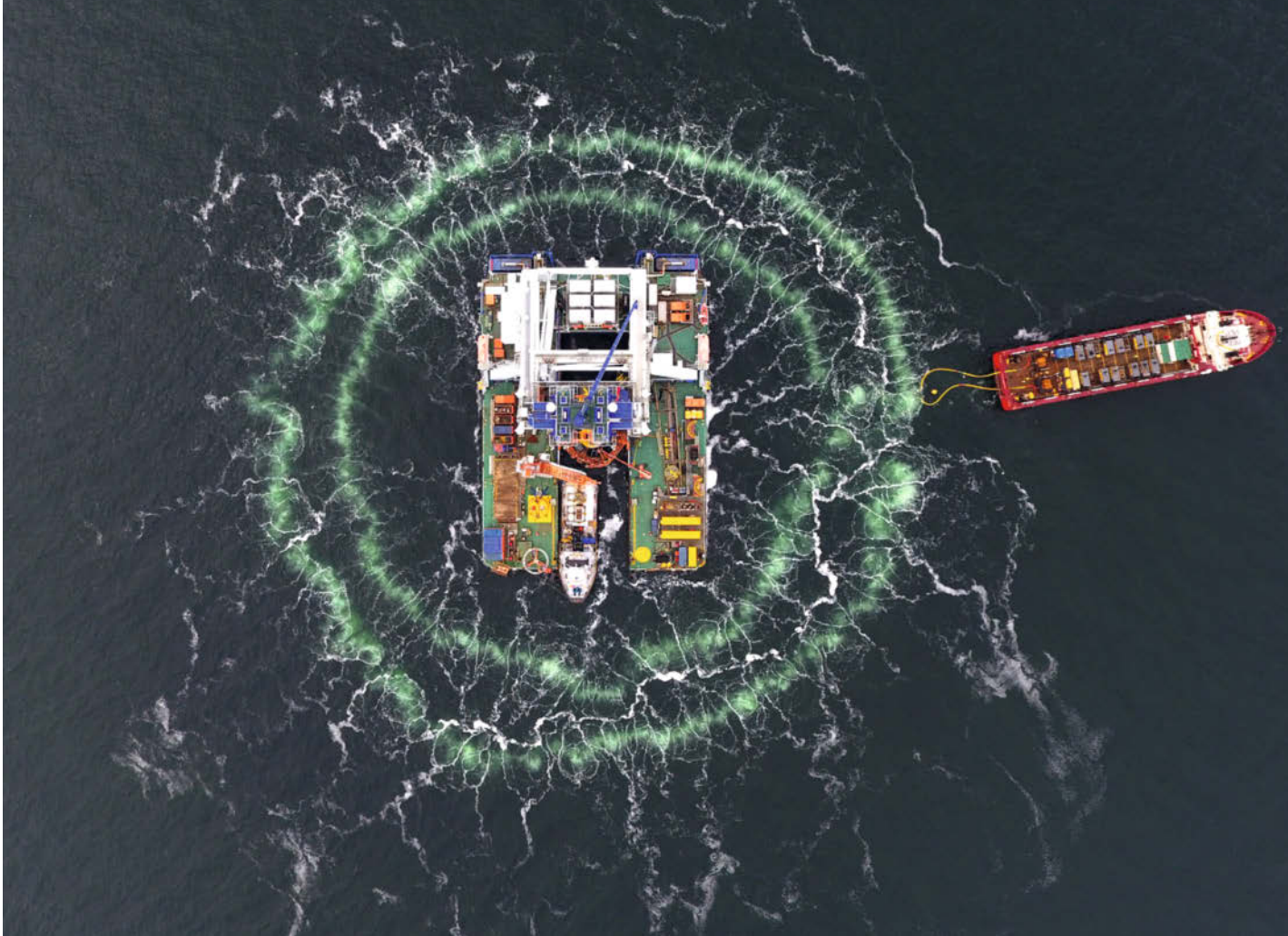
Ein Blasenschleier in 60 Metern Abstand zur Baustelle soll Meeresbewohner vor dem Lärm der Rammarbeiten schützen. Mit zunehmender Wassertiefe verringert sich allerdings seine Wirkung.
